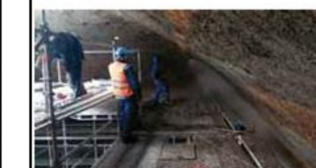
Realizácia sanácie kupoly objektu Spilky, obnova krycej vrstvy plošnou aplikáciou reprofilačných mált v hrúbke 20 mm
