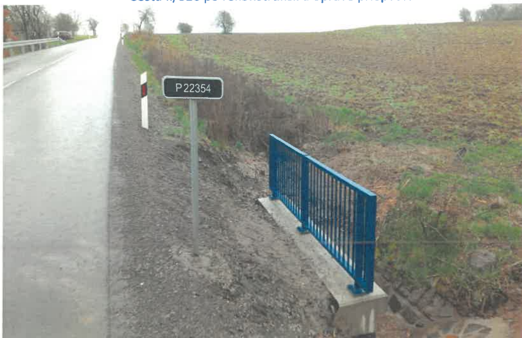
Cesta II/526 po rekonštrukcii a oprave priepustov
