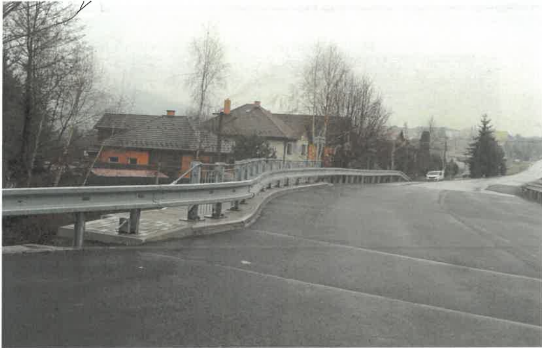
Most M230, ev. č. 526-048, po rekonštrukcii
