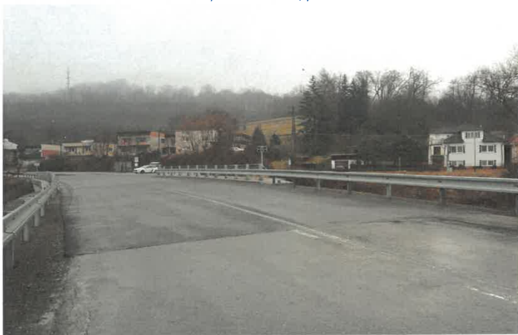
Most M230, ev. č. 526-048, po rekonštrukcii
