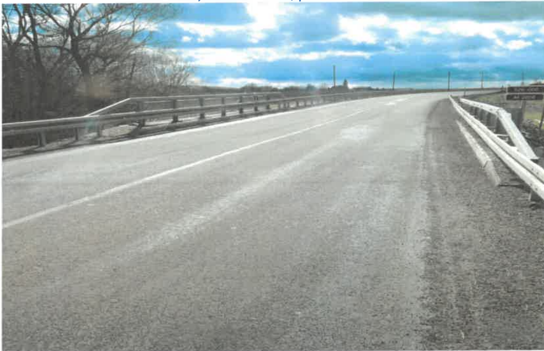
M2608, ev. č. 526-008, po rekonštrukcii
