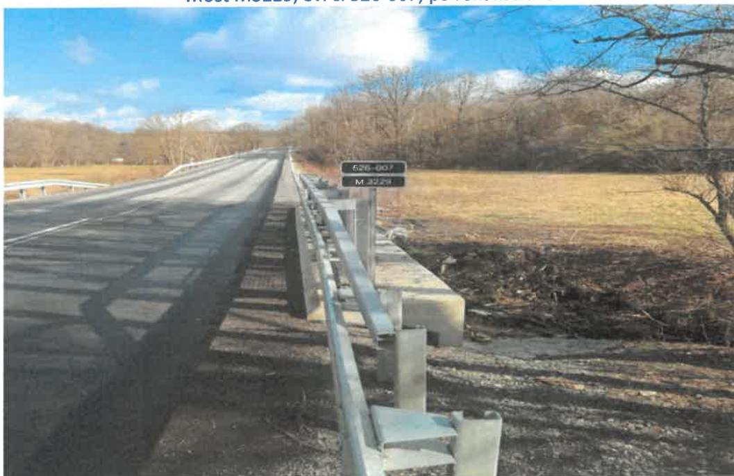
Most M3229, ev. č. 526-007, po rekonštrukcii
