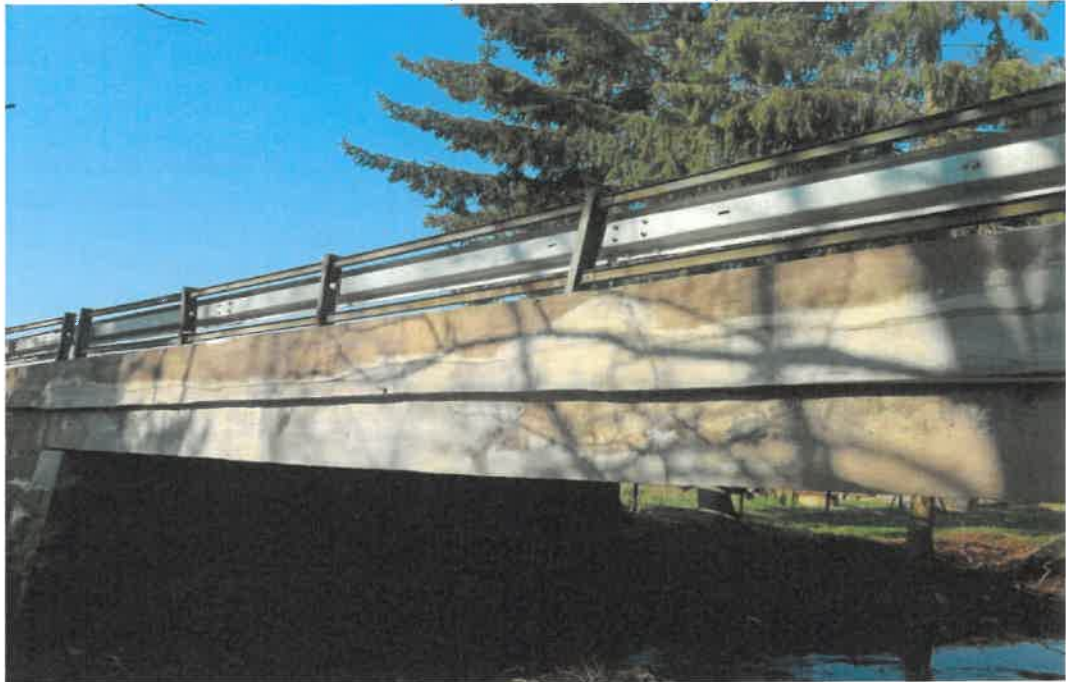
Most M4857, ev. č. 2483-006, po oprave
